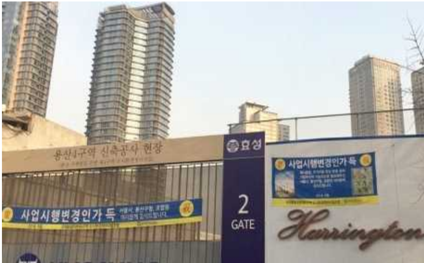
[그림 4] 2020년 완공될 용산구 주상복합 아파트 공사현장
